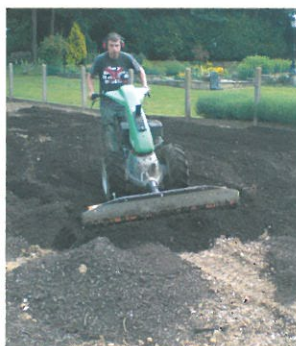
Cette plaque niveleuse vibrante de 1,5 m de travail permet de niveler le terrain et de pousser les matériaux (terre, compost, grave..).
